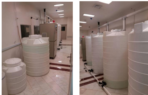
Planta de desinfección de agua industrial NajafAbad-Esfahan -2020 Capacidad: 40 kg FAC/d
